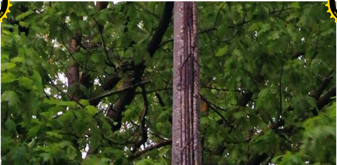
—Wniosek -wymiana-słupów-oświetleniowych-w-dzielnicy-Ligota-Panewniki (5).jpg—
