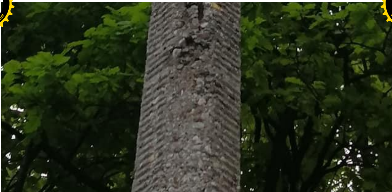
—Wniosek -wymiana-słupów-oświetleniowych-w-dzielnicy-Ligota-Panewniki (18).jpg—
