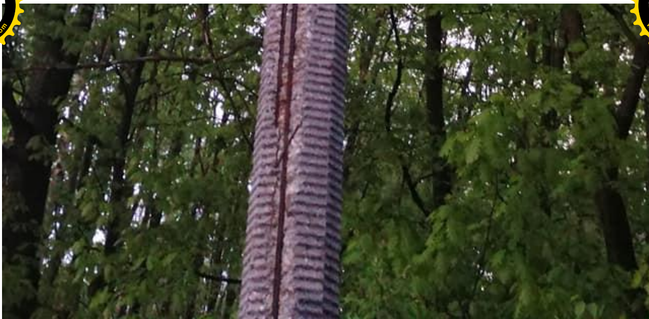
—Wniosek -wymiana-słupów-oświetleniowych-w-dzielnicy-Ligota-Panewniki (13).jpg—
